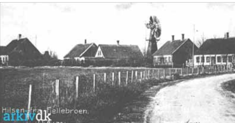
Strandhuse Fjællebroen 5600 Faaborg ( https://arkiv.dk/vis/1176064 ), hvor motoren er bygget i huset som ligger bag møllen
